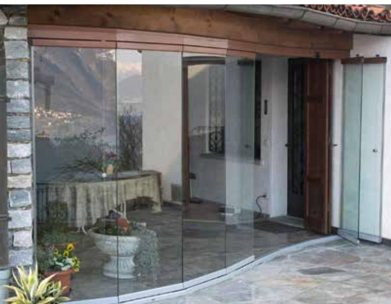
Con il sistema d'impacchettamento delle ante, in estate, il vano rimane utilizzabile come d'abitudine, senza parti fisse; in caso di vento, il vantaggio dei pannelli indipendenti è che si possono chiudere o posizionarli secondo l'esigenza, permettendo ugualmente l'aerazione del vano.
